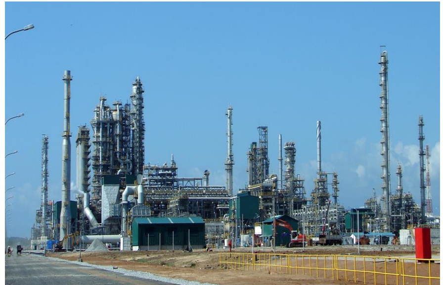
Nhà máy lọc dầu Dung Quất
