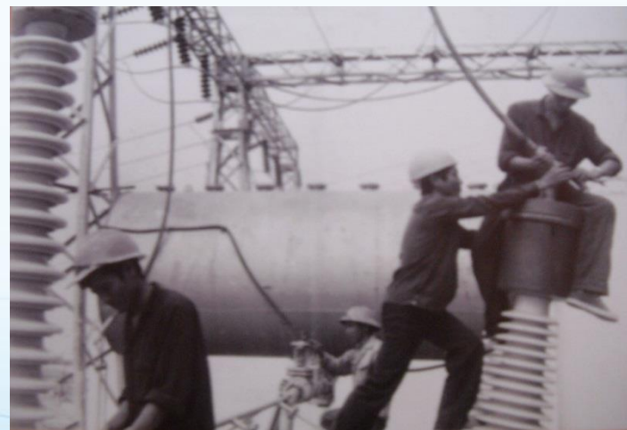
Đoàn viên thanh niên tích cực hoàn chỉnh máy biến thế tại nhà máy nhiệt điện Phả Lại năm 1983
